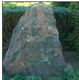
Glasplaat gemonteerd d.m.v. RVS afstandhouders op natuursteen
